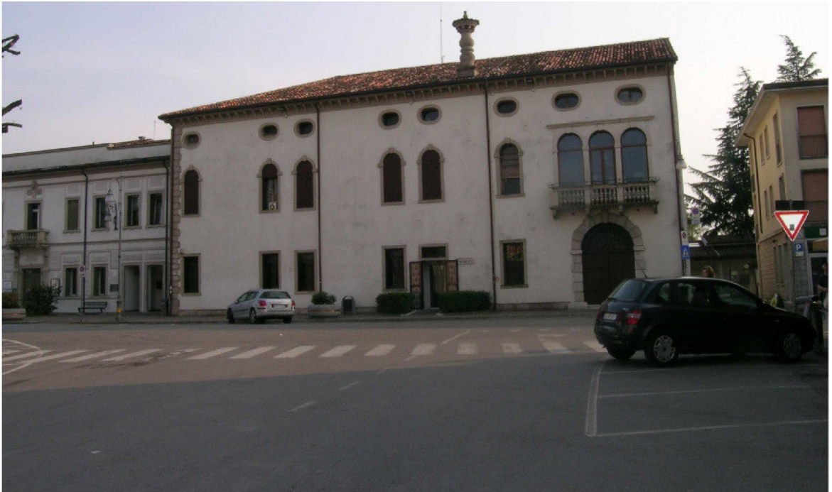
Fig. 4.17 - Vazzola Palazzo Tiepolo verso la piazza.
