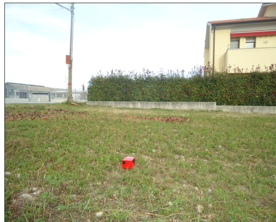
Foto di cantiere
