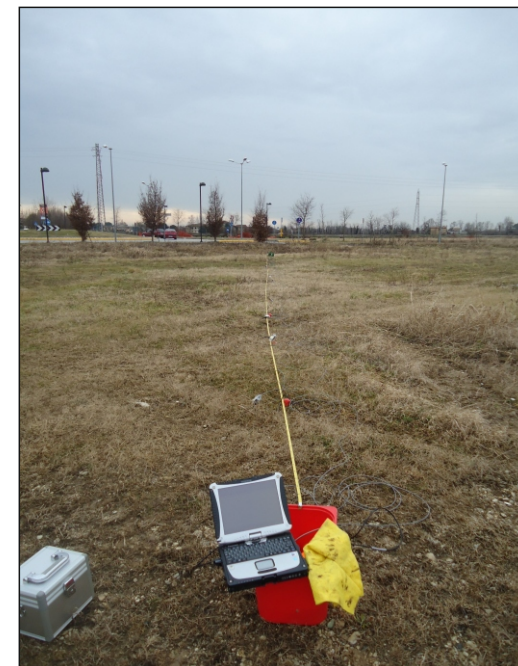
Foto di cantiere
