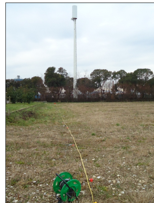
Foto di cantiere
