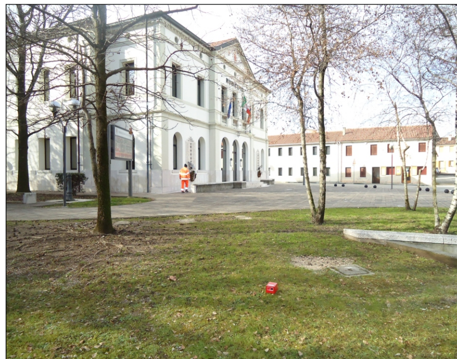
Foto di cantiere
