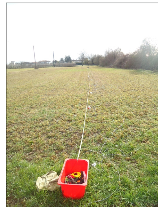
Foto di cantiere
