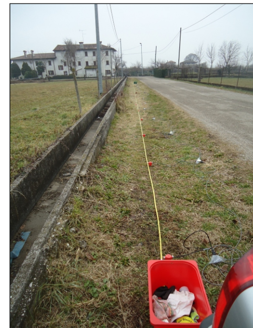
Foto di cantiere
