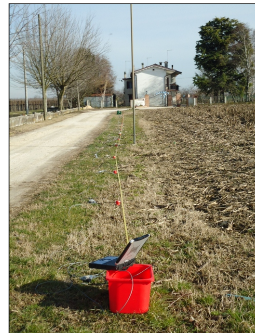
Foto di cantiere
