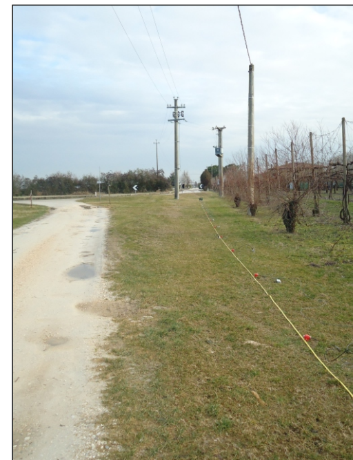
Foto di cantiere
