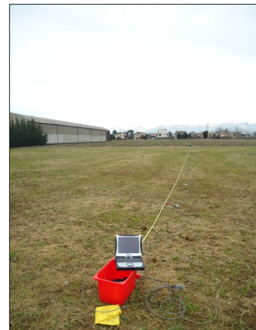
Foto di cantiere
