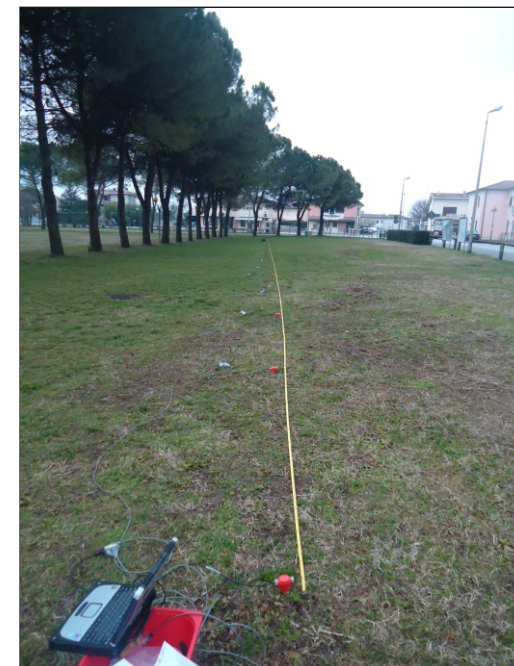
Foto di cantiere
