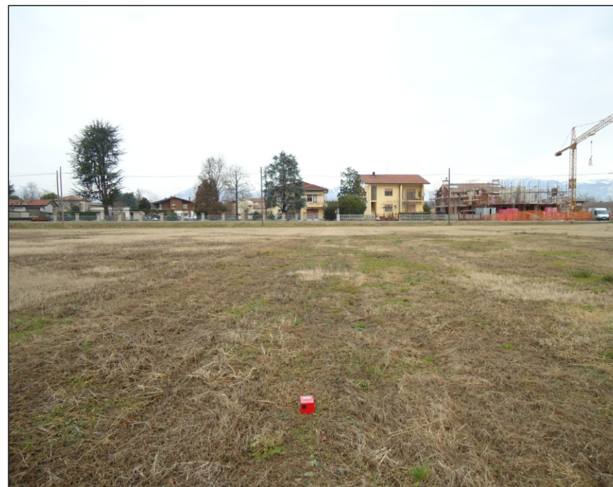
Foto di cantiere
