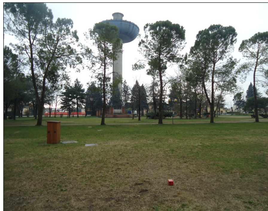
Foto di cantiere
