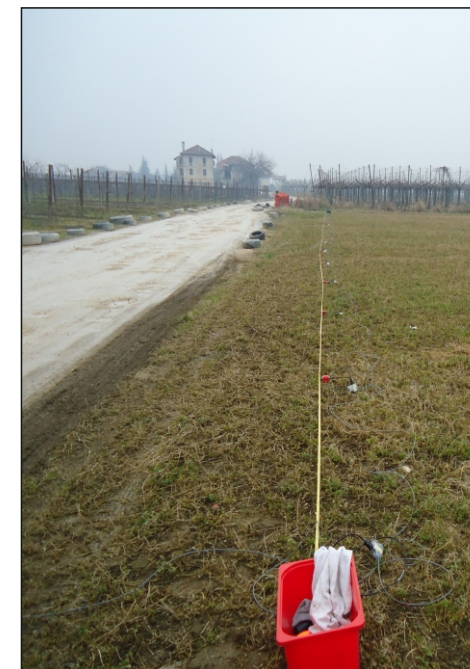
Foto di cantiere
