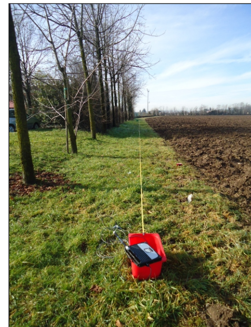
Foto di cantiere
