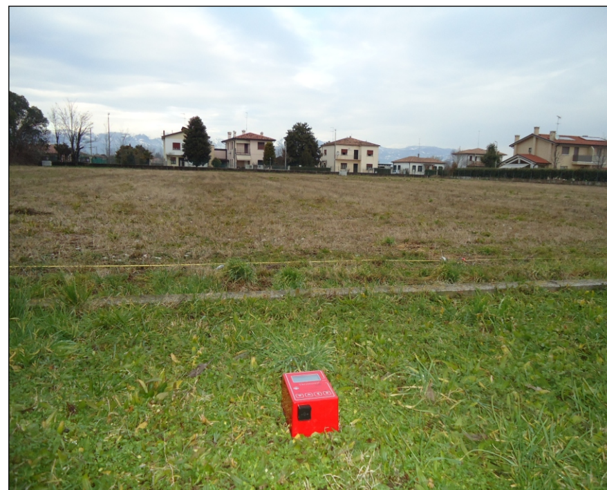
Foto di cantiere
