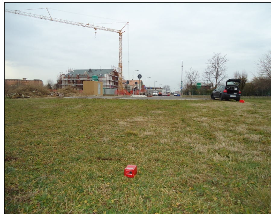
Foto di cantiere
