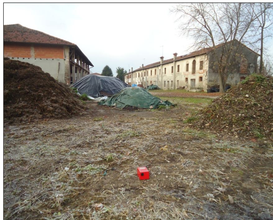
Foto di cantiere
