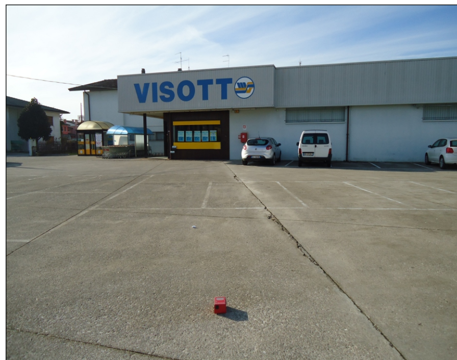
Foto di cantiere
